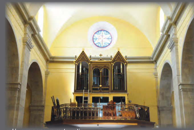
L'orgue en cours restauration
