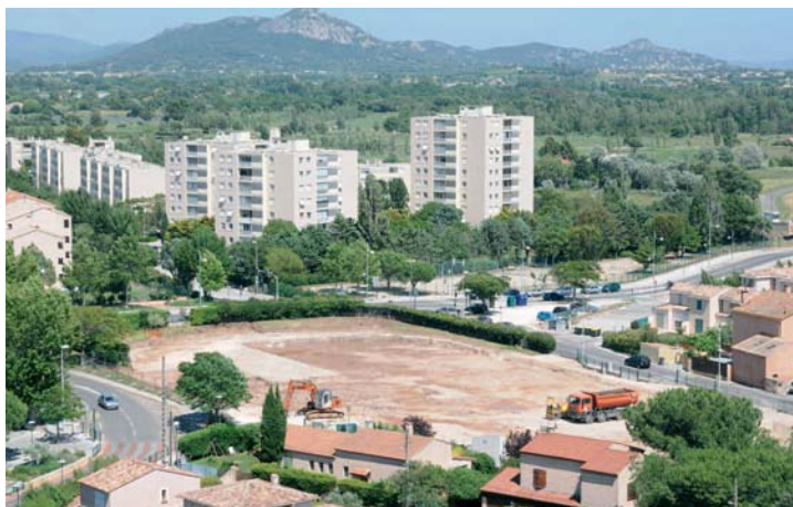
Santi. Fin de la phase de démolition - terrassement avant reconstruction
