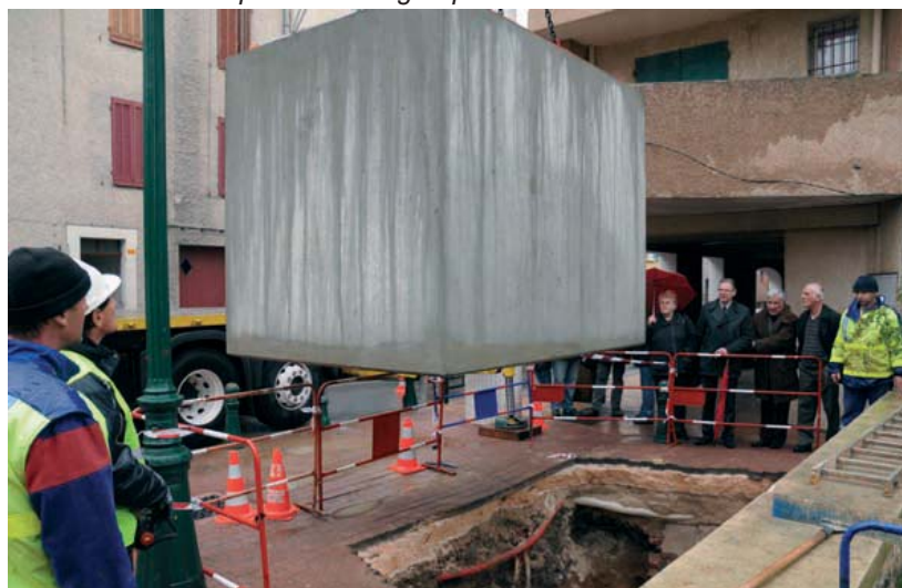
Fin janvier, les 1 ers containers enterrés ont été installés avenue Autran.
