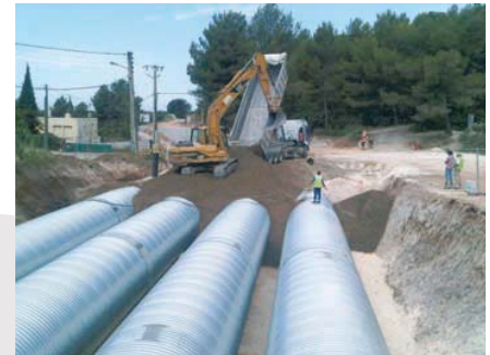
Les travaux de réseaux d'eau ont été réalisés. Un bassin de rétention d'eau a également été créé.
